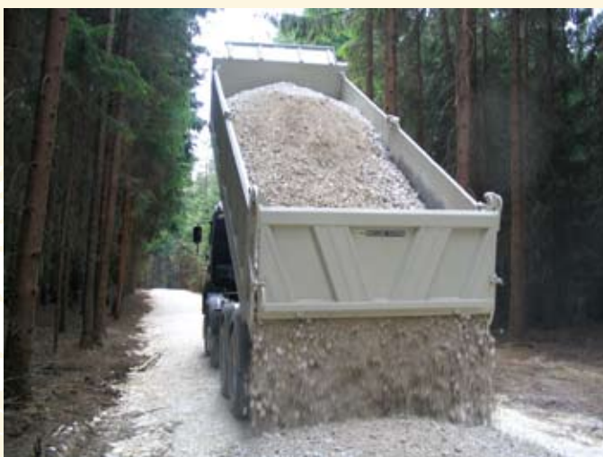
Aufbringen der oberen Tragschicht mit Mineralbeton 0/32
